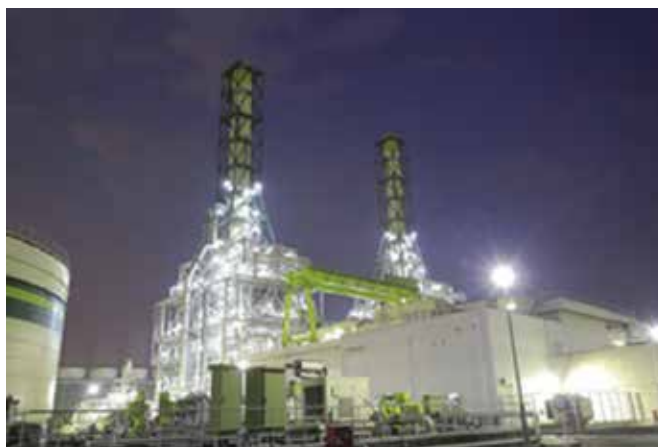
川崎天然ガス発電所の夜景
