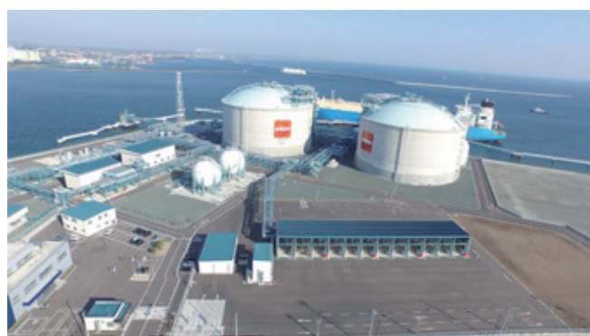
Hachinohe LNG Terminal
