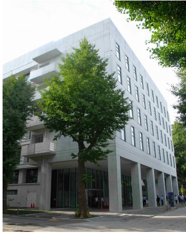
「ENEOSラボ」が入居する「環境エネルギー棟」外観
