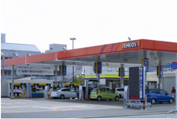
海老名中央水素ステーションの外観
