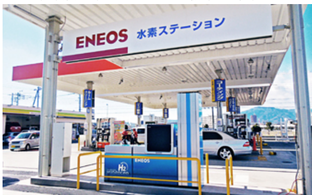
<水素充填機(手前)とガソリン計量機(奥)の設置状況>
