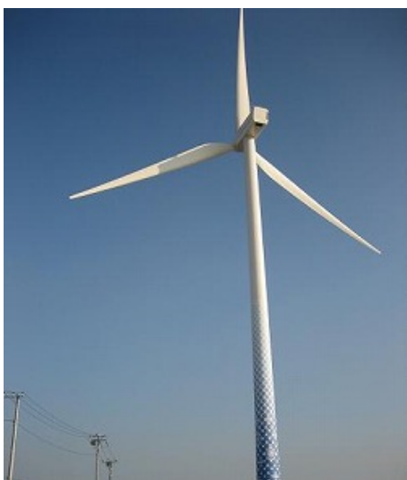
順調に稼働し発電する風車
