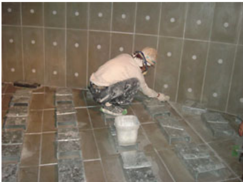
レコサルを用いたエコサルファー防食工法
