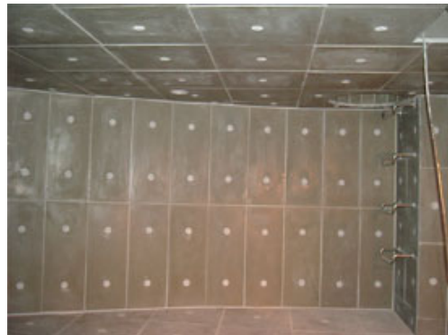
施工後の神戸市垂水処理場汚泥濃縮棟
