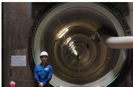
海底トンネルの出入口(浮島側)
